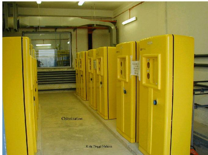
**Рис. 9** Дозирующее оборудование для газообразного хлора для протяженных трубопроводов. Максимальная загрузка хлора 200 кг/час
