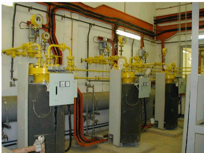
**Рис. 7** Испаритель жидкого хлора с подводными трубами для жидкого хлора и отводным трубопроводом для газообразного хлора, оборудованный регуляторами давления
